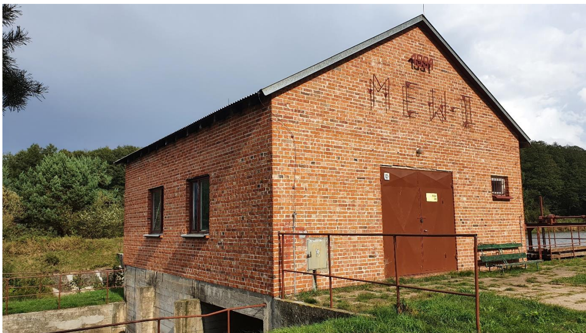
FOTOGRAFIA 12. BUDYNEK MAŁEJ ELEKTROWNI WODNEJ NR 2 [ŹRÓDŁO: INSTYTUT OZE]
