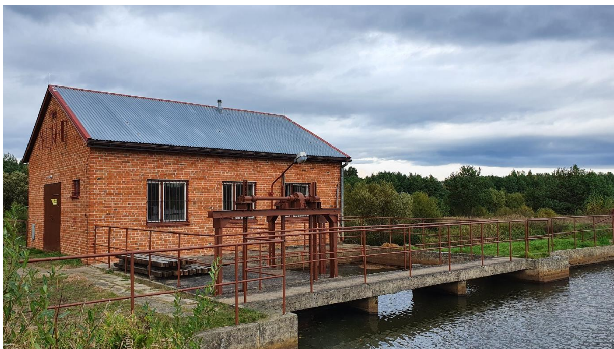
FOTOGRAFIA 14. BUDYNEK MALEJ ELEKTROWNI WODNEJ NR 3 [ŹRÓDŁO: INSTYTUT OZE]
