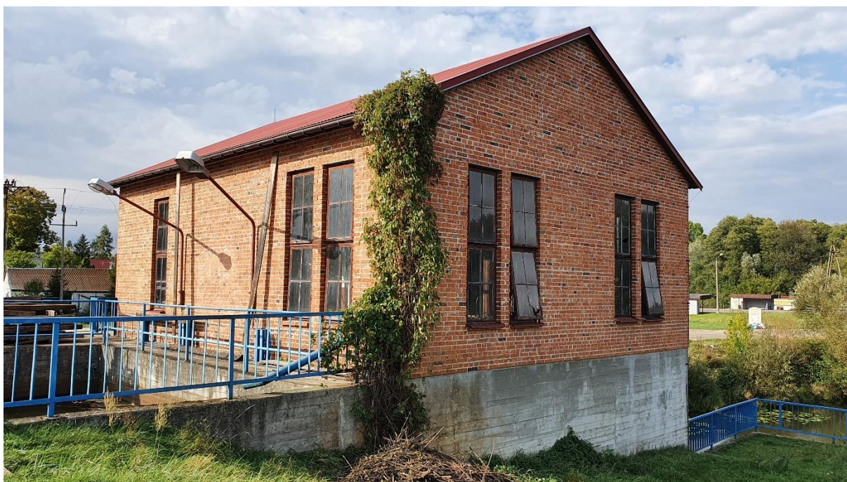
FOTOGRAFIA 1. WINOBLUSZCZ TRÓJKLAPOWY PORASTAJĄCY BUDYNEK MEW NR 1 [ŹRÓDŁO: INSTYTUT OZE]
